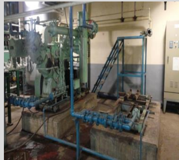
노후장비 철거 후 설치사례
