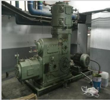
노후장비 철거 후 설치사례
